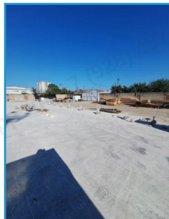
21 августа Базы колонн на химических анкерах
