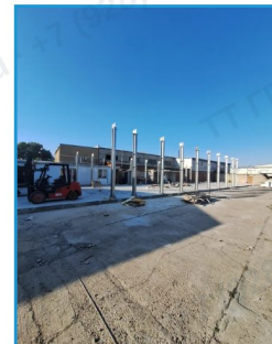
24 августа К вечеру — ряд из 12 колонн
