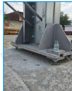
Крупно База колонны: рёбра, шайбы, анкеры
