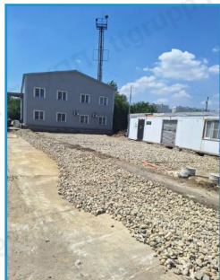
28 июля Основание засыпано щебнем
